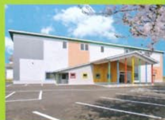
板倉シティホール
